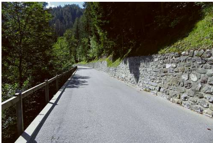
Kurz vor Baubeginn: Zwischen Inner- und Usser Praden muss die Kantonsstrasse umfassend saniert werden.
