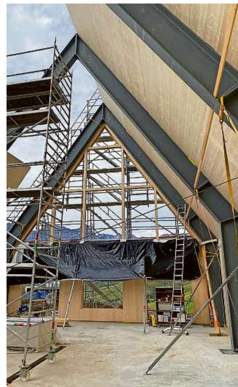
Zwei Führungen stehen beim Neubau der KuhBar auf dem Programm. Bild zVg
