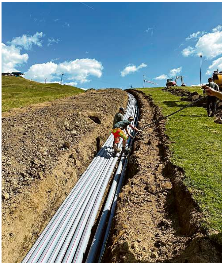
Im Rahmen der technischen Beschneigung wurden neue Leitungen verlegt.
